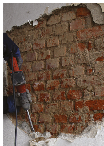
Remover rebocos degradados
