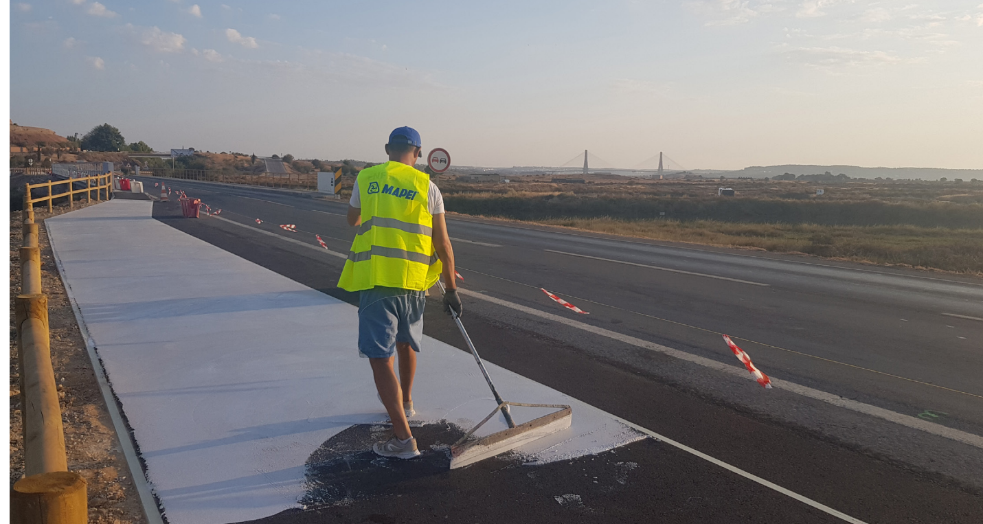
EM CIMA. Aplicação do produto Mapecoat TNS White Base Coat ABAIXO. Aplicação do produto Mapecoat TNS Race Track Dark Green TNS
