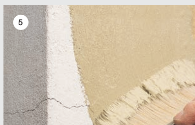
SLIKA 5: 3. korak – nanos zaščitno dekorativne barve ELASTOCOLOR na temeljni premaz ELASTOCOLOR PRIMER.
