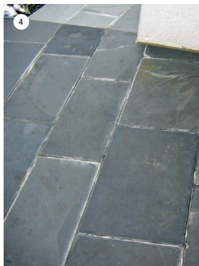
SLIKA 3: Simulacijski test z vlažnim polstom. SLIKA 4: Izcvetanje kalcijevega karbonata na fugah oblog iz skrilavca kot posledica polaganja v neprimeren sistem malt.
