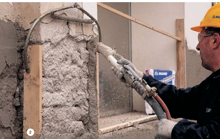
SLIKA 2: Strojni nanos POROMAP-a DEUMIDIFICANTE.
