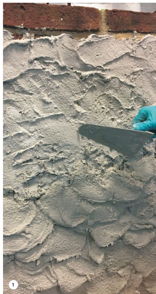
SLIKA 1: Ročno nanašanje sušilnega ometa POROMAP DEUMIDIFICANTE.
