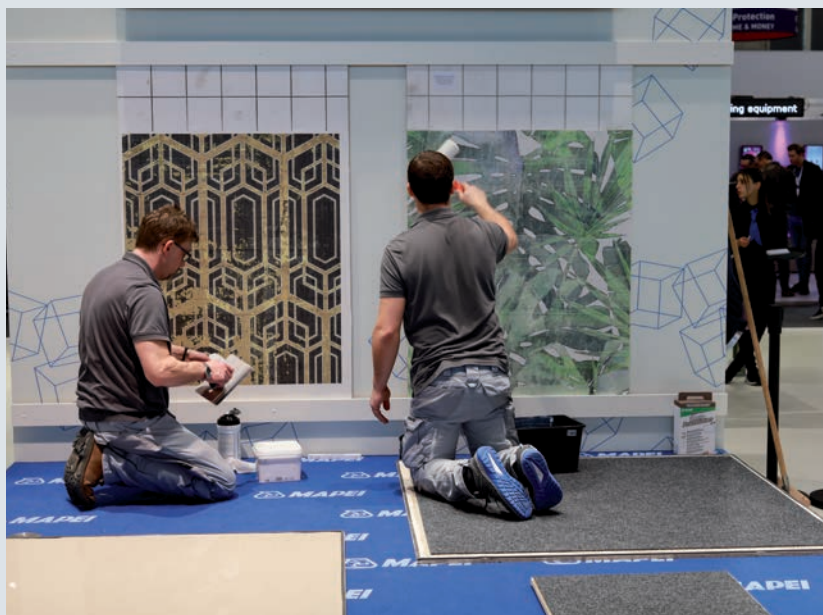
Prikaz vgradnje steklenih vlaken z uporabo izdelkov iz linije Decor.
