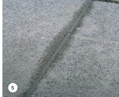
SLIKA 5: Madeži ob dilatacijskih regah zaradi uporabe neustreznega tesnilnega kita. Pri izvedbi dilatacij je za kamen pravilna izbira nevtralna tesnilna masa MAPESIL LM, ki preprečuje obarvanje kamna.
