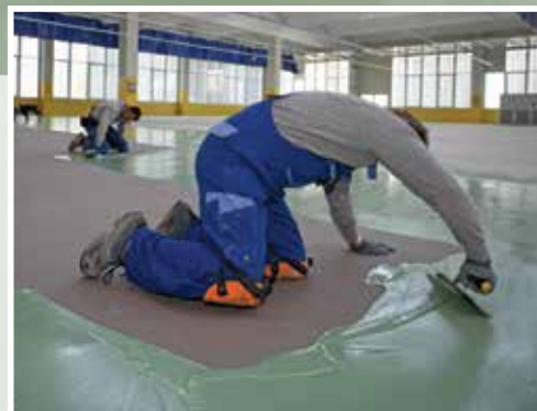
APLIKÁCIA Mapecfloor I 300 SL STIERKOU
