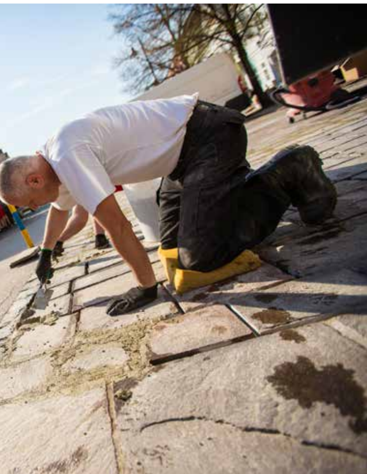
FOTO. Historické centrum Košíc pred, počas a po aplikácii systému MAPESTONE
