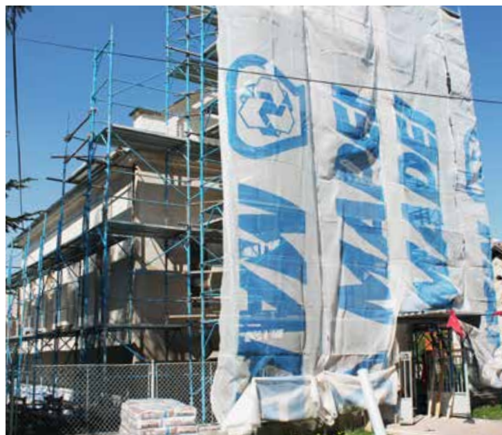
DOLE. Kostol počas rekonštrukcie
