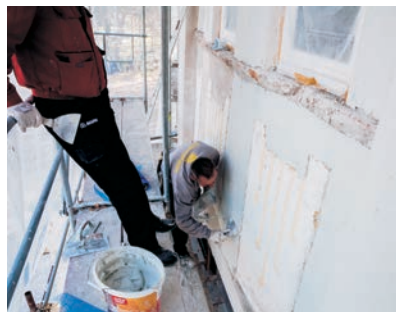
SLIKE 1 i 2: Nanošenje maltera PLANITOP 200.
