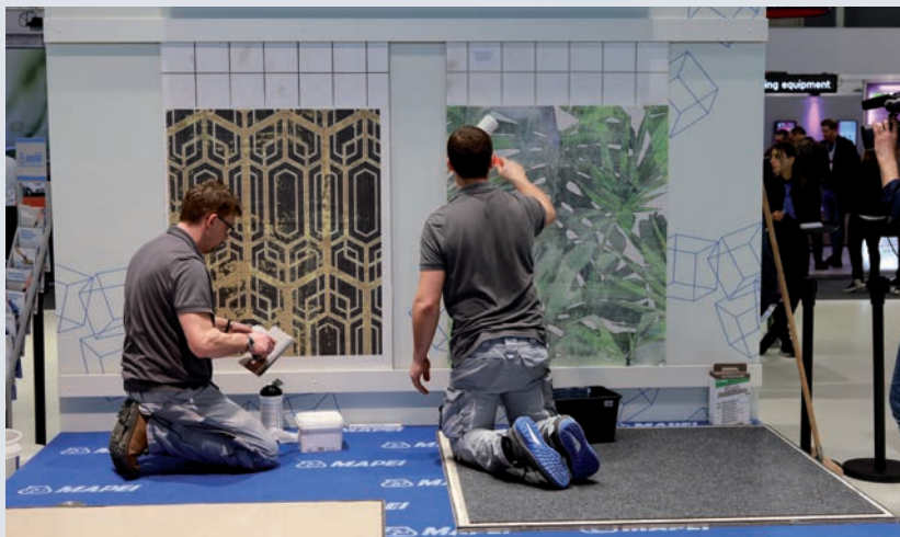
Polaganje dekorativnih obloga od staklenih vlakana proizvodima iz linije Decor.
