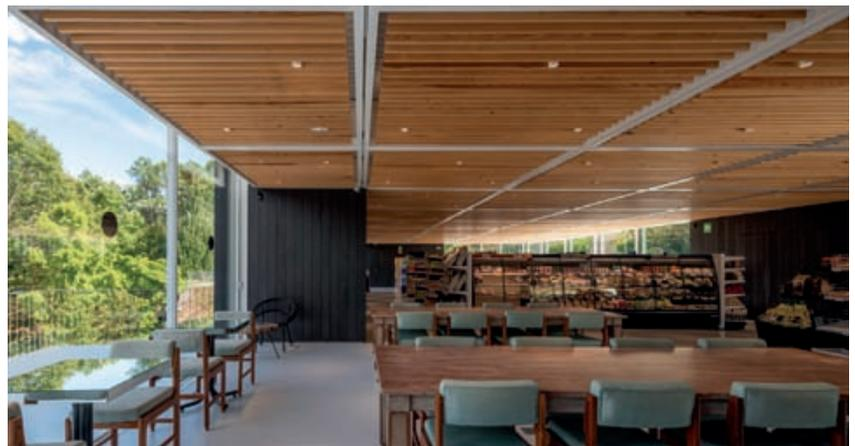
realizada mediante perfiles metálicos en dos planos (a modo de cubrición estérea con apoyos perimetrales). El espacio central queda totalmente abierto y diáfano, dotándose de gran versatilidad y polivalencia.
