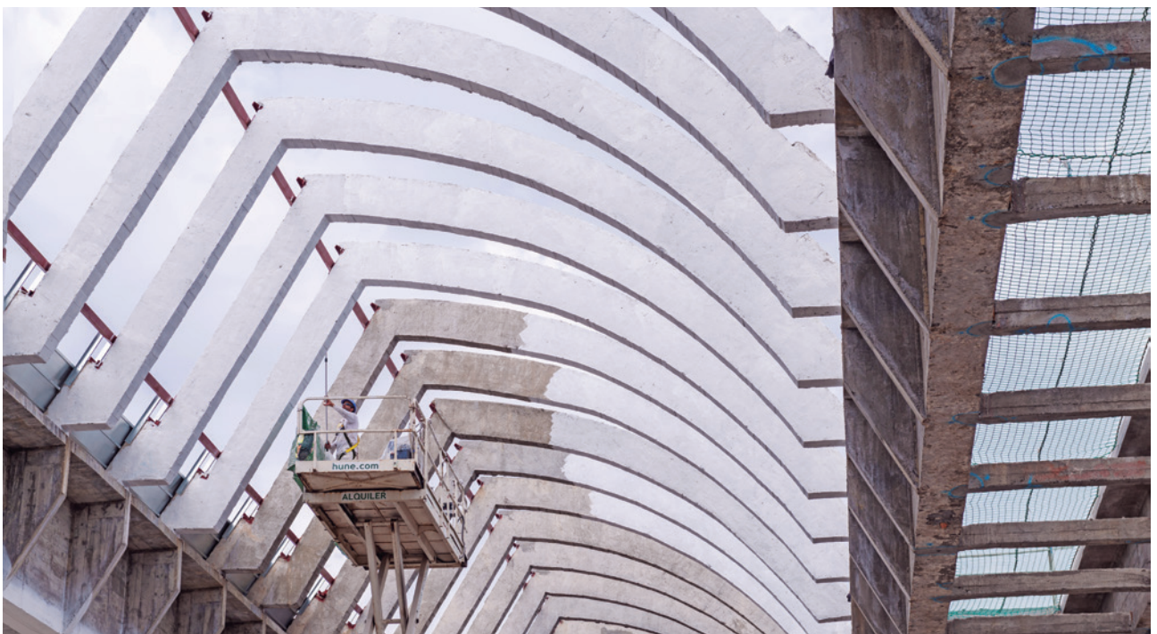
Protección frente a la carbonatación
