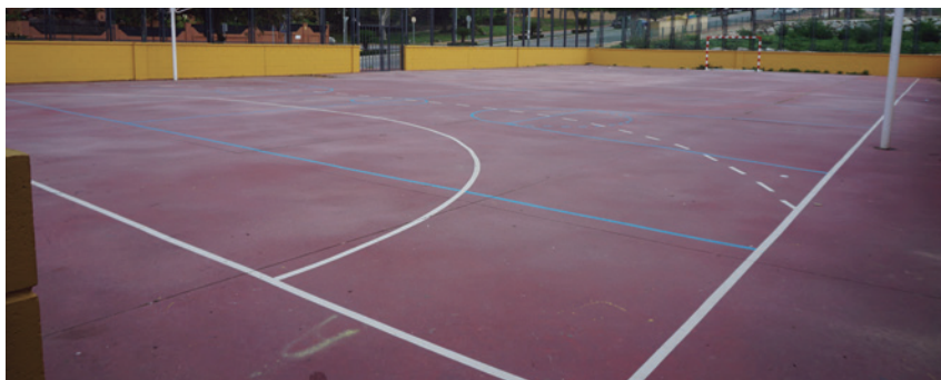
ARRIBA. Estado de la pista polideportiva antes de la intervención
