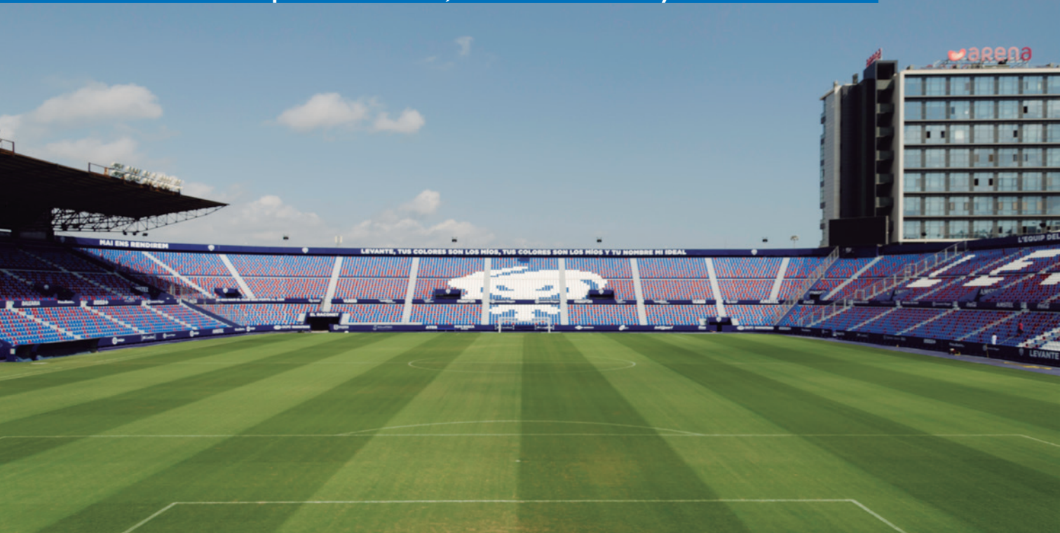
Vista general interior del estadio del Levante
