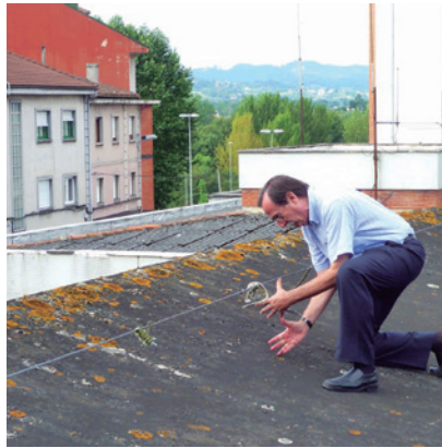
Segundo proyecto de refuerzo, año 2016. Verificación del espesor exacto y del trazado catenárnico de las ocho láminas
