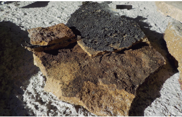
Restos de la capa superior que debió ser reconstruida
