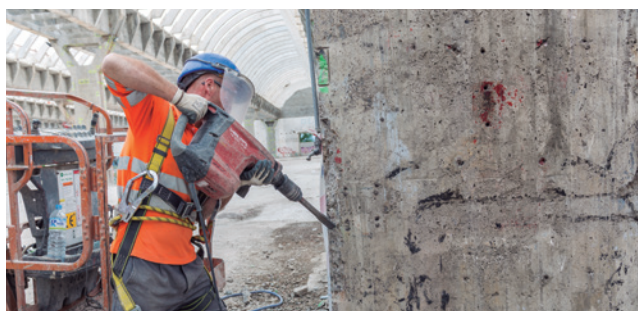
A LA IZQUIERDA. Preparación de superficies. A LA DERECHA. Tratamiento de pasivación de las armaduras
