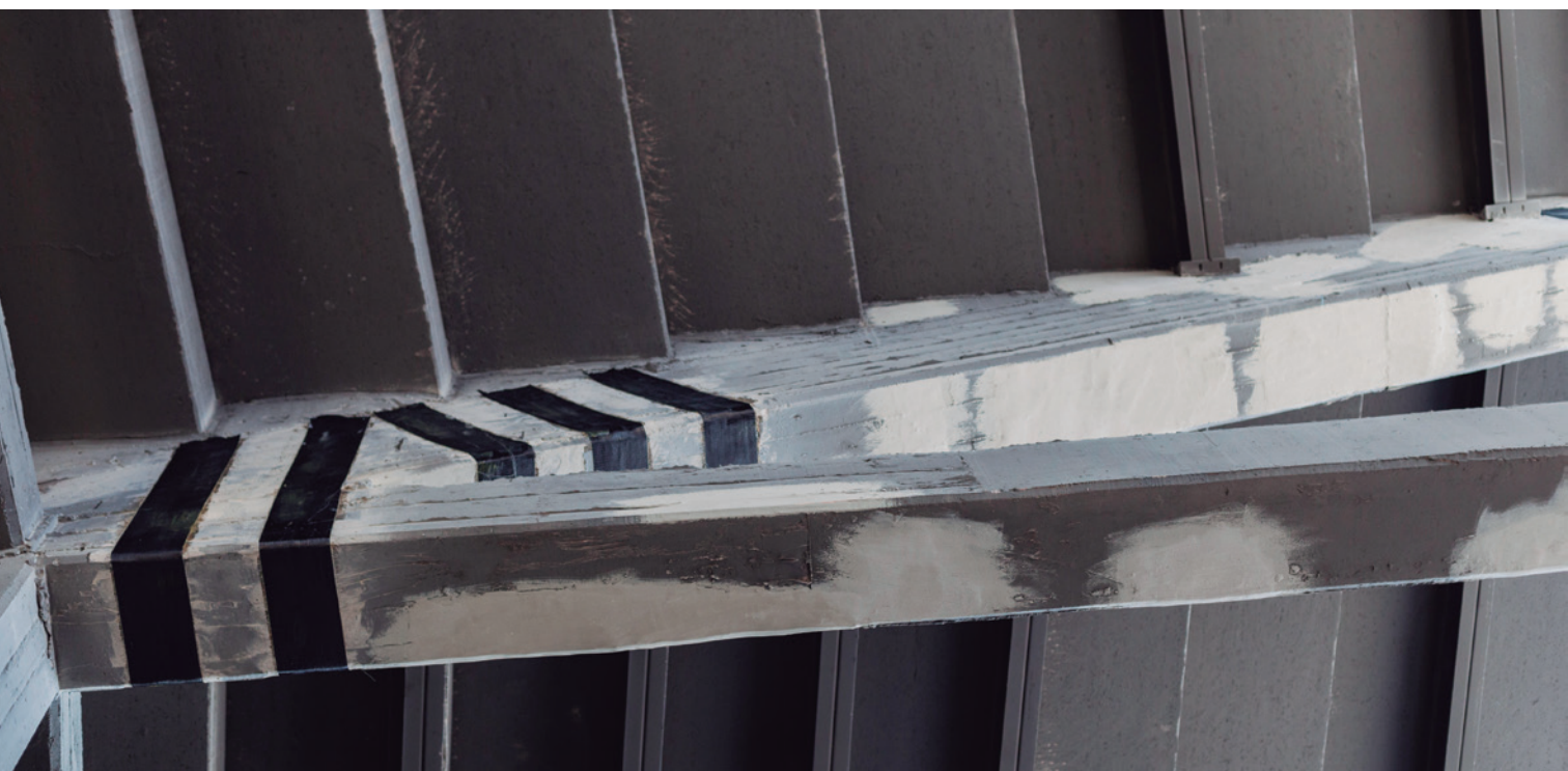
Refuerzo estructural con fibra de carbono (MAPEWRAP)
