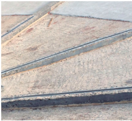
Refuerzo superior de los nervios e inferior de las láminas con fibras de carbono
