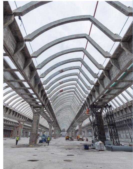
Inicio de los trabajos de rehabilitación
