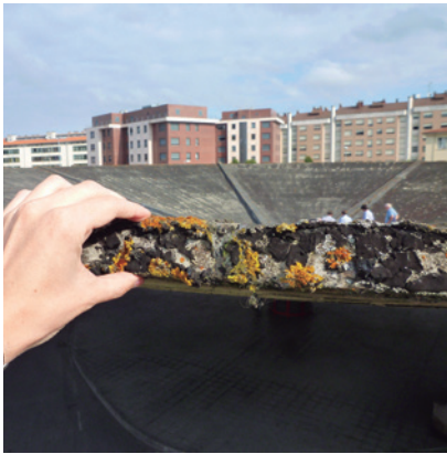
Segundo proyecto de refuerzo, año 2016. Verificación del espesor exacto y del trazado catenárnico de las ocho láminas
