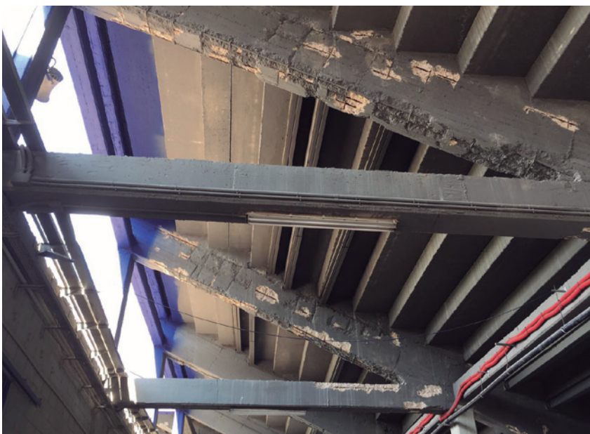
ARRIBA. Saneado de los elementos de hormigón en mal estado
