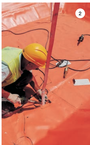
SLIKA 1: Polaganje PVC sintetičke folije MAPEPLAN UG 20.
