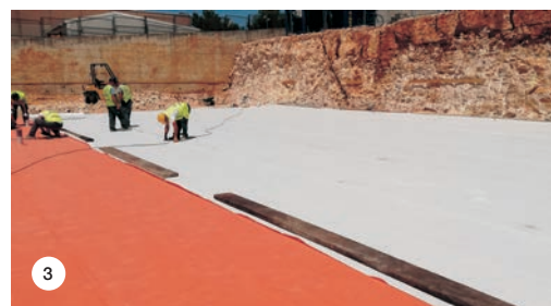
SLIKA 1: Polaganje PVC sintetičke folije MAPEPLAN UG 20.
