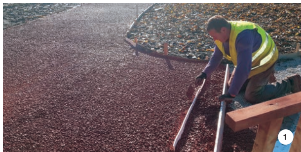
SLIKA 1: Ugradnja propusnog betona.
