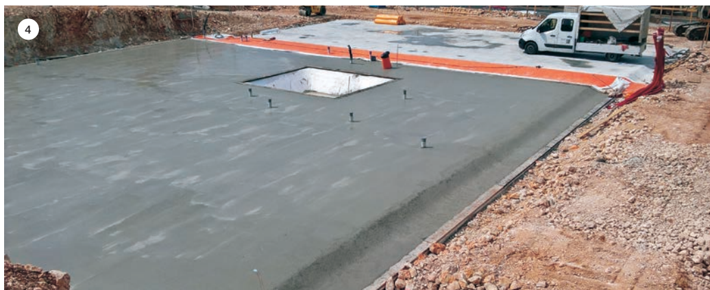
SLIKA 4: Hidroizolacijska PVC folija MAPEPLAN UG 20 položena je na geotekstil.
