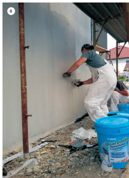
SLIKA 10: Nanošenje završnog premaza SILANCOLOR TONACHINO PLUS na fasadu stambenog objekta.
