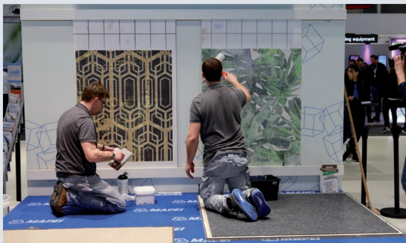
Polaganje dekorativnog fiberglassa proizvodima iz linije Decor.
