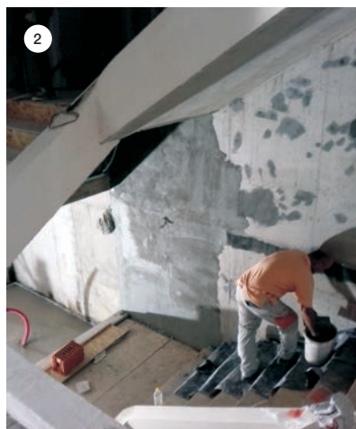
SLIKA 2: Nanošenje polimer-cementnog hidroizolacijskog morta MAPELASTIC FOUNDATION.
