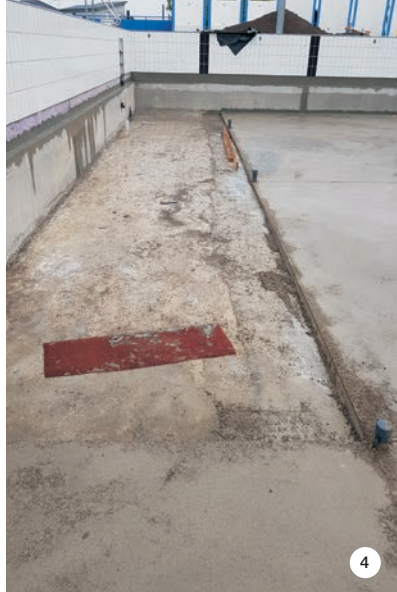
SLIKE 4, 5: Saniranje dna betonske školjke – PLANICRETE i TOPCEM.
