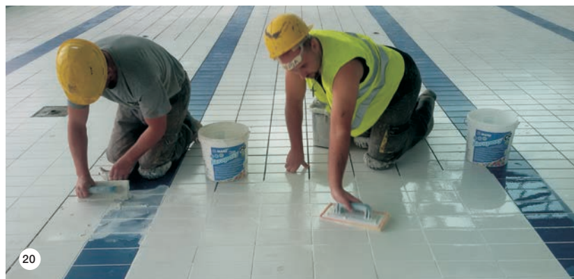
SLIKA 17: Lijepljenje staklenog mozaika ADESILEX-om P10 i ISOLASTIC-om.
