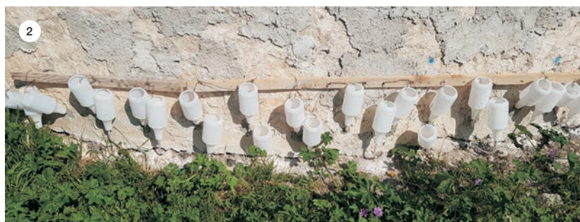
SLIKA 2: Raster pozicija za konsolidacijsko injektiranje.
